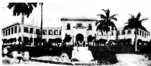
Magnífico edificio inaugurado en Matanzas y destinado a Instituto de Horticultura.
